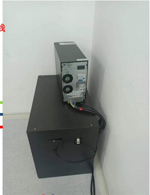
UPS和稳压器，稳压器和实验桌排插间接线为6mm<sup>2</sup>铜线连接。准备至少9个国标10A的三孔插座供电脑、显示器、打印机及仪器使用。
